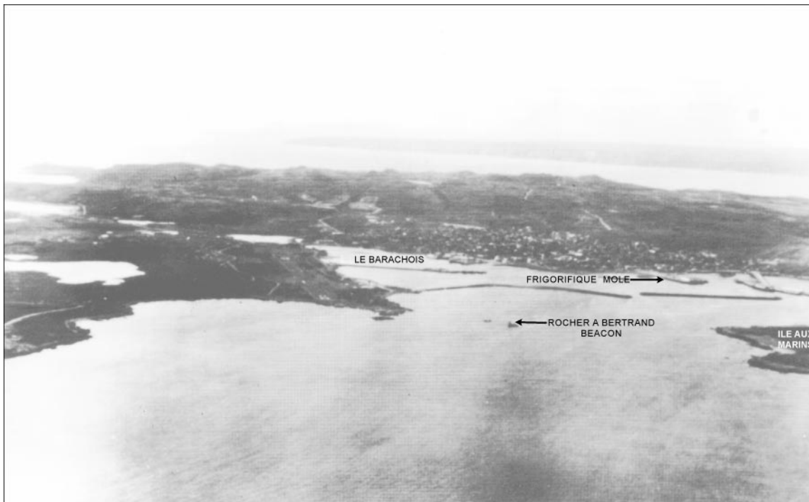
Port de Saint-Pierre from SE
